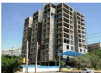
▲ پروژه باغ بهار در حال ساخت
